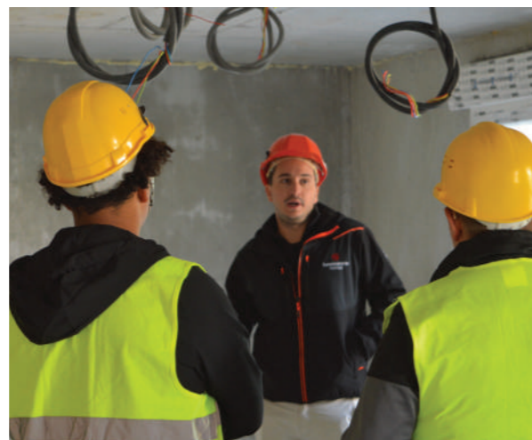
Visite chantier des élèves
